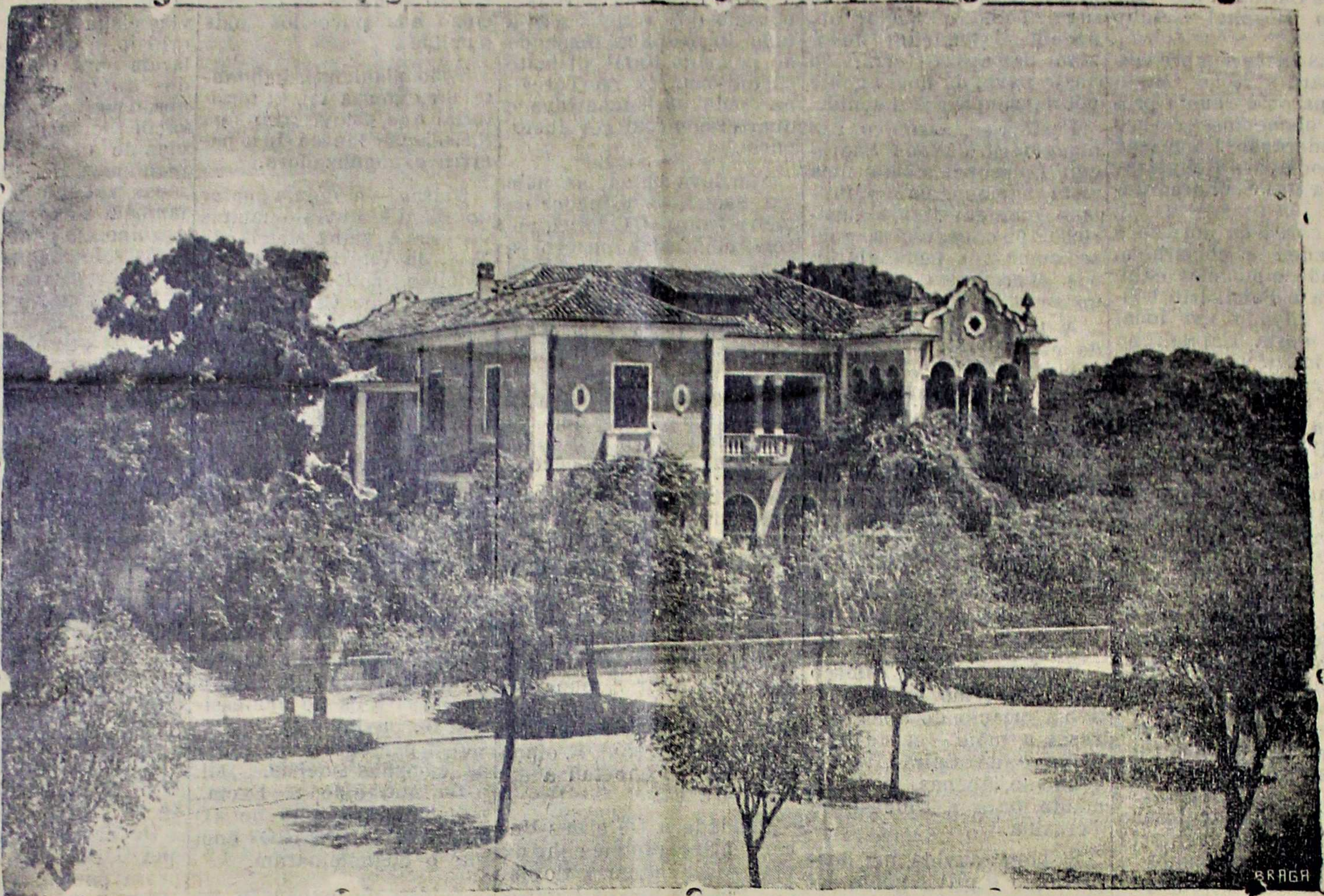
O novo Paço Episcopal «Nossa Senhora das Graças», à Avenida Getúlio Vargas
